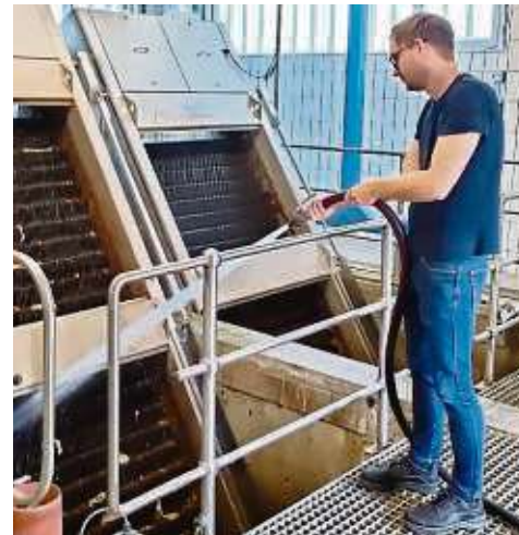
Proben aus den Belebungsbecken zu entnehmen gehört ebenso zu den Aufgaben in der Anlage, wie den sogenannten Rechen zu reinigen. Dort wird der größte Schmutz aus dem Abwasser gefiltert.
