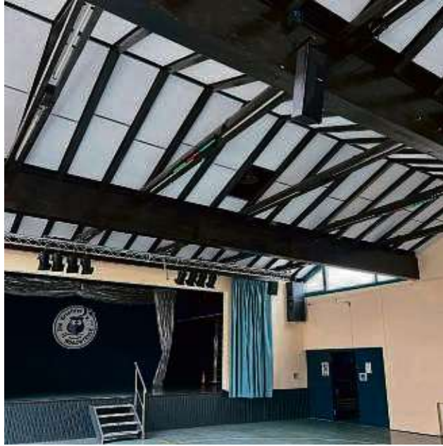
Eine neue Deckenverkleidung sorgt dafür, dass bei Veranstaltung in der MZH die Akustik nicht leidet. FOTO: PM
